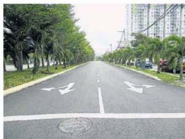
■珍珠坊路口工程完工后，承包商重鋪整條道路。
