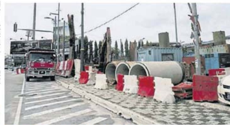
■位於吉特拉廣場的工地，工程仍在進行中。
