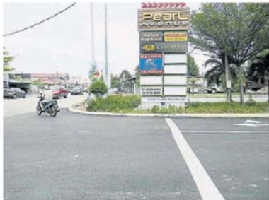
■錫米山珍珠坊路口工程已竣工。
