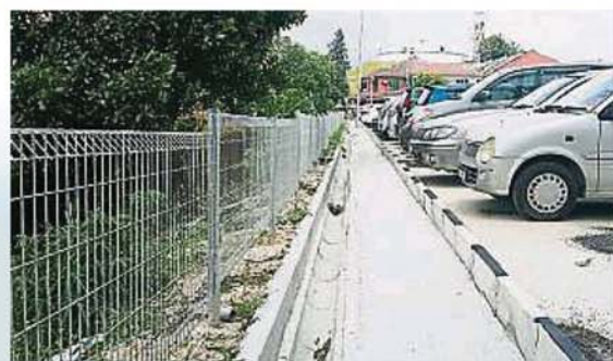
承包商已完成大部分基建工作，包括筑起沟渠。
